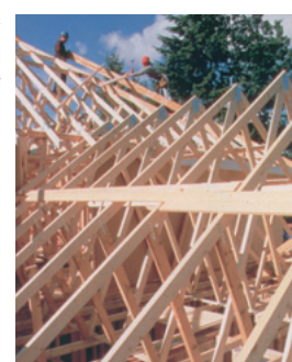
▶ 建築現場での小屋組工期を大幅に短縮できます。
