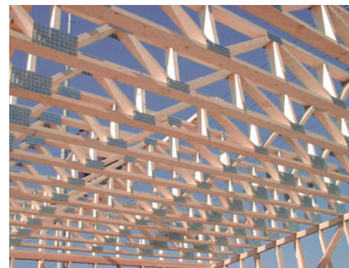
▲設備の変更が容易に行える、床トラス。
