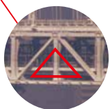
▲鉄橋などにもトラス構造が採用されています。
