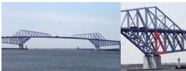
〈東京ゲートブリッジ〉東京ゲートブリッジの特徴的なフォルムは、羽田空港に近接しているため航空機の飛行に支障のない高さ(98.1m)に抑え、一方で船舶の航路を跨ぐために桁下高(54.6m)を確保する必要があるため、トラス構造を採用して安全性と耐久性を確保しています。□全長:2,618m □構造高:87.8m □桁下高:54.6m □橋脚間航路幅:310m(東京港第三航路) □開通:平成24年2月12日
