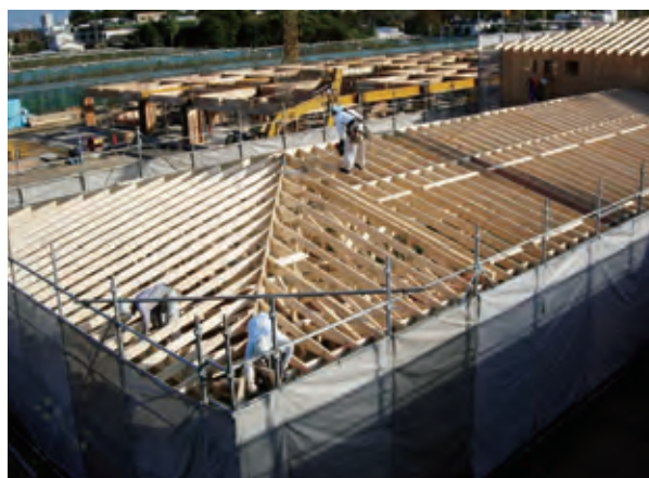
▲寄棟部のトラス設置事例
